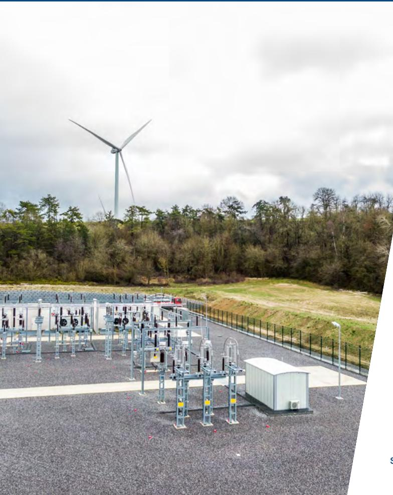
**L'innovation industrielle que représente le « Poste Source Express » est illustrée par le projet réalisé à Mont-Pinson. Il s'agit d'une installation inédite, qui permet un gain de temps grâce à deux grands principes : la modularité et la standardisation.**
